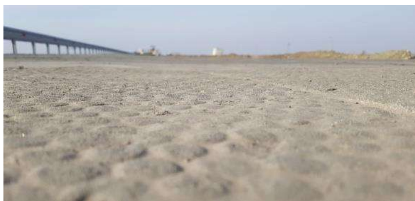
Рисунок 12 – Рифленое улучшенное цементобетонное покрытие на автодороге Кызылорда – Павлодар – Успенка – граница РФ, км 1251
