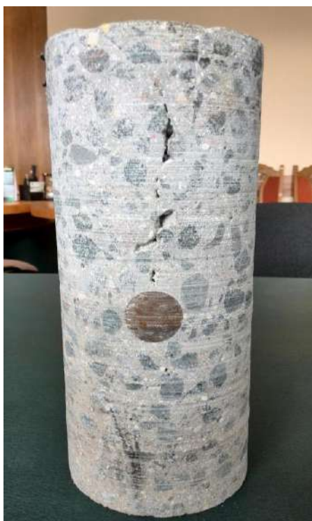
Рисунок 8 – Дефект в бетоне, возникающий при погружении металлических дюбелей (трещина над погруженной арматурой)
